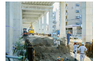
高い耐震性を確保するための地中梁を施工している
