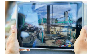
撮影写真を確認。設計図書通りに施工できているかを細かくチェックして記録に取るのも大事な仕事
