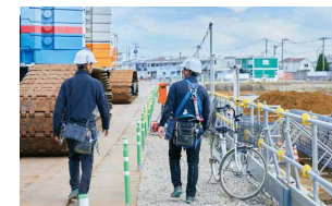
会社は違えど現場を進めるメンバー同士の協力は欠かせない
